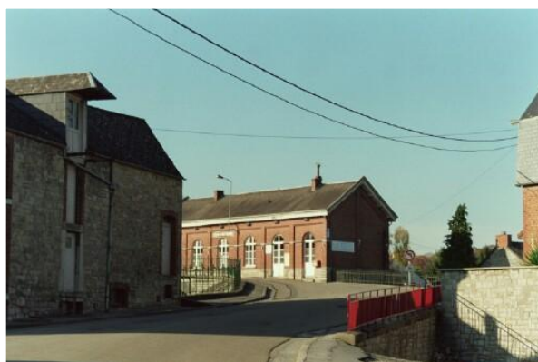
Gare pont de Cerfontaine
