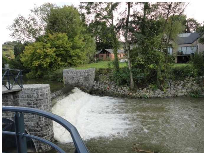
Déversoir du Hameau à Ham-sur-Heure
