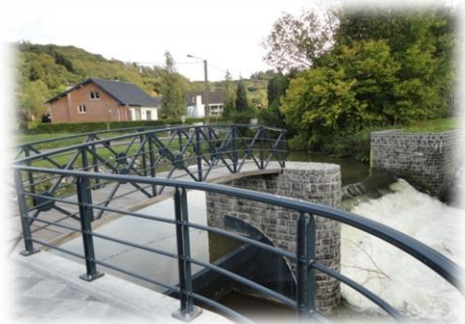
déversoir du Hameau, Ham-sur-Heure
