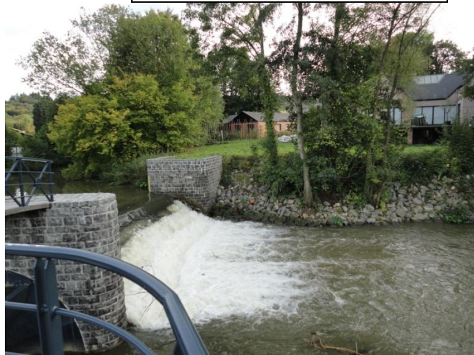
Déversoir du Hameau à Ham-sur-Heure
